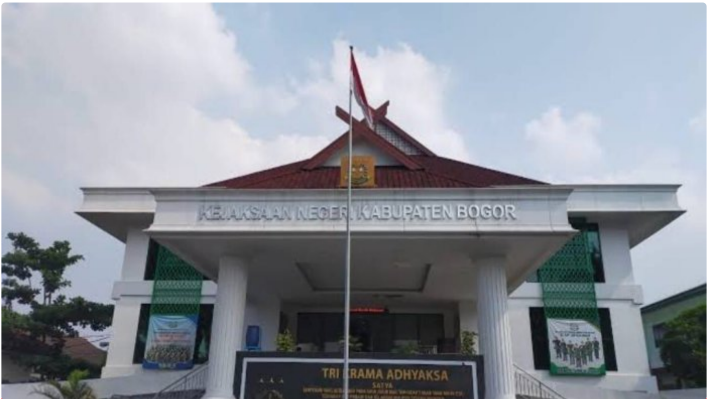
Photo: Gedung Kejari Kabupaten Bogor
