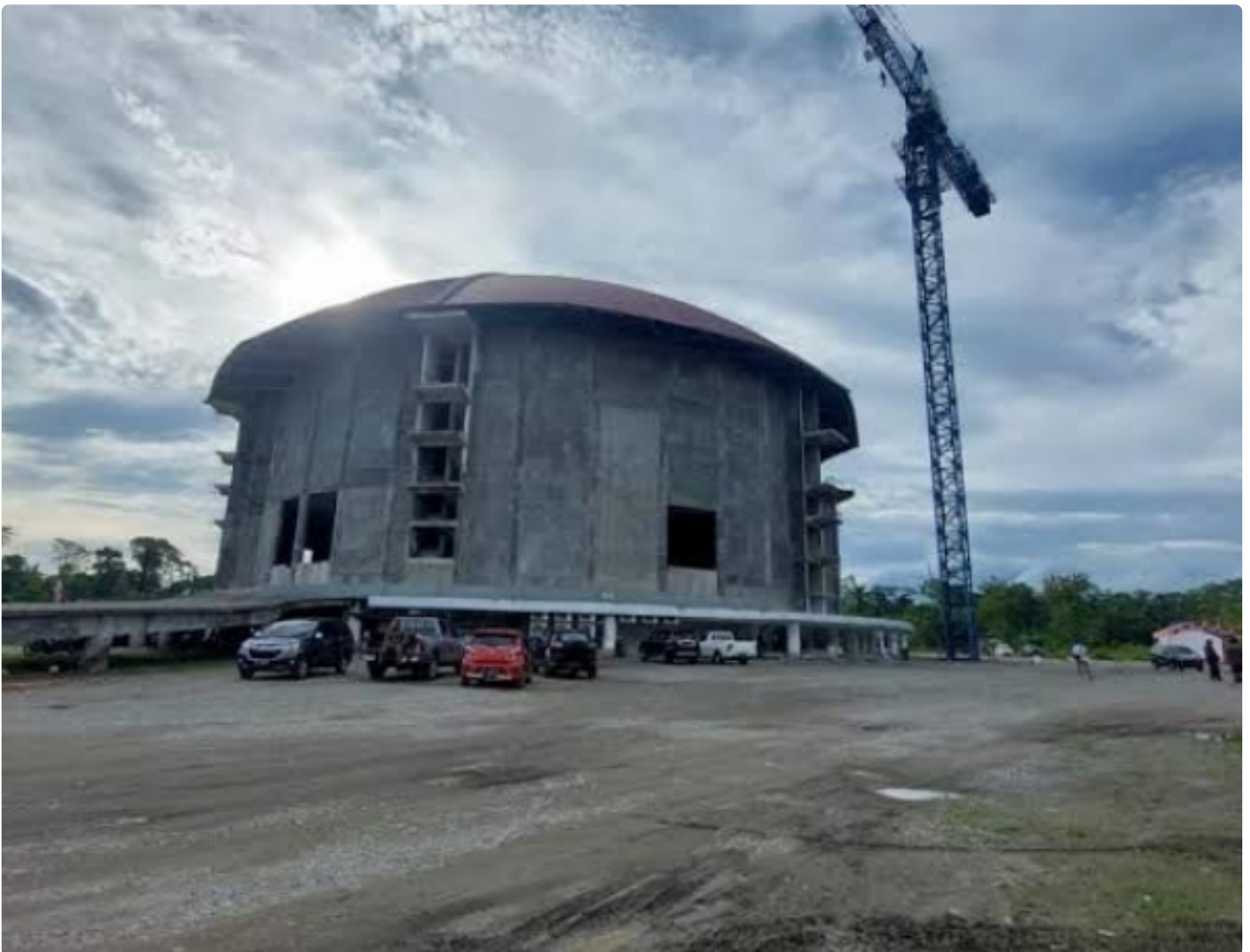
Pembangunan Gereja Kingmi Mile 32
